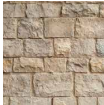
Muratura in pietra/calcestruzzo
