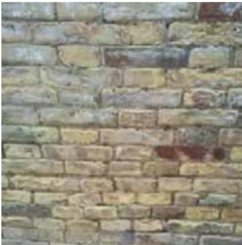
Muratura in laterizio pieno
