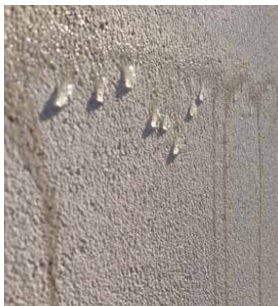
Figura 20 La rasatura AIR TERM NHL presenta spiccate caratteristiche idrofobizzanti che favoriscono l'allontanamento delle acque meteoriche.
