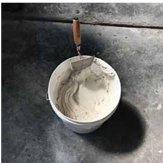
Figura 21 Dopo l'impasto, AIR TERM NHL si presenta omogeneo, cremoso e privo di grumi. La sua posa in opera risulta semplice e veloce.
